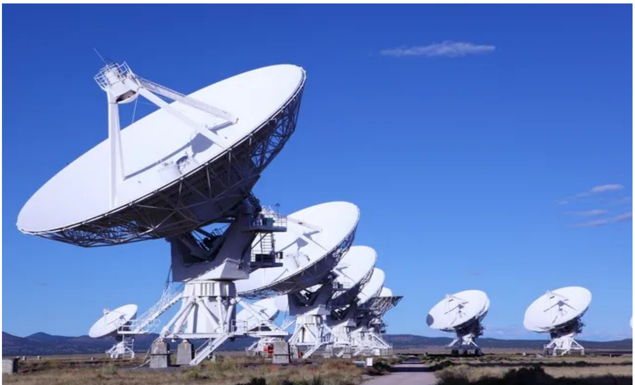
Rysunek 4. Sieć interferometryczna Very Large Array składa się z 27 ogromnych anten, każda o średnicy 25 metrów, co pozwala im działać podobnie jak jeden wielki teleskop o średnicy 36 kilometrów. (Źródło: Shutterstock)
